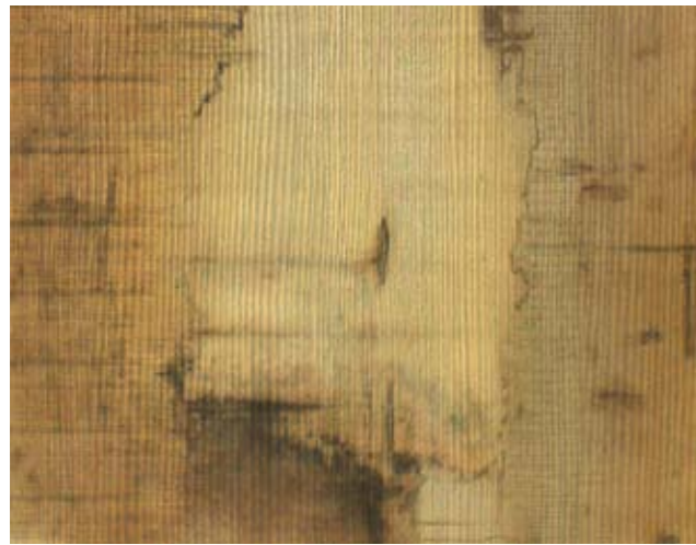
LEGNO MARCIO ROTTEN WOOD
